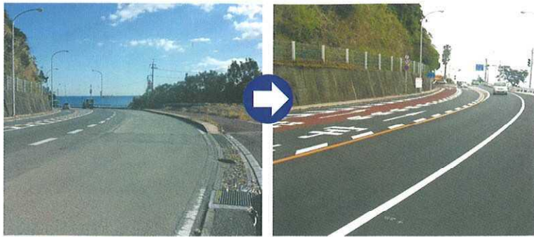
同社が手掛けた施工前(左)と施工後(右)の道路。急カーブを緩やかにすることで見通しが良くなり、安全性が向上したことが分かる。
